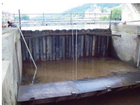
bestehender Revisionsverschluss OW
