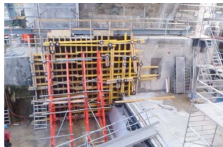
Schalungsarbeiten und Seitenschleiffläche
