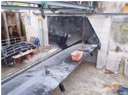
Einbau Fischbauchklappe mit Verschubplattform
