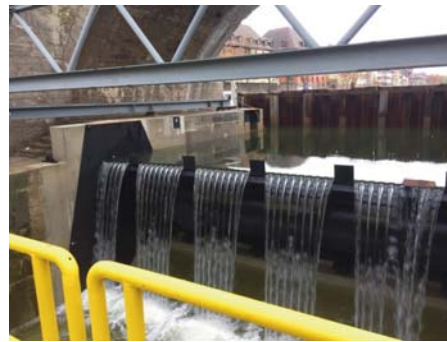
Inbetriebnahme neue Fischbauchklappe
