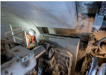
Bild 5: Ringbau im Schutze des Schildschwanzes.
