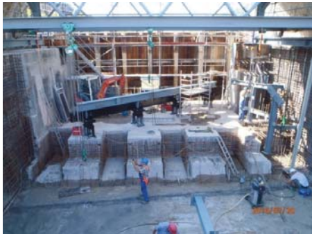
Einbau neuer Sohlbalken
