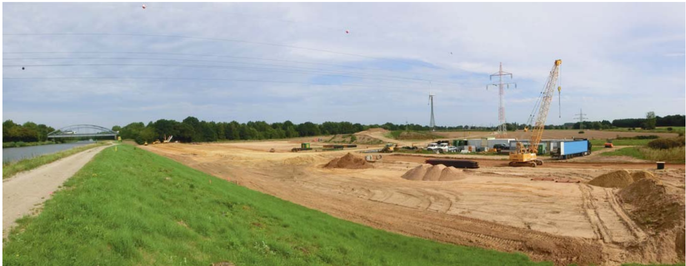
Bild: Baufeld Containerterminal RegioPort Weser im August 2017
