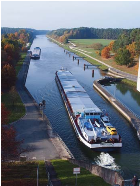
Abb. 2: Unterwasser der Schleuse Eckersmühlen
