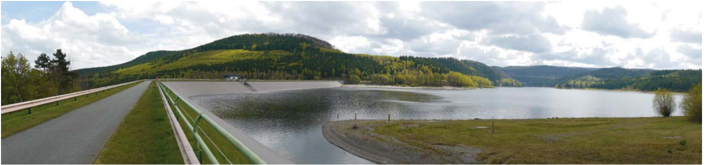
Bild 1: Panoramablick über die Talsperre
