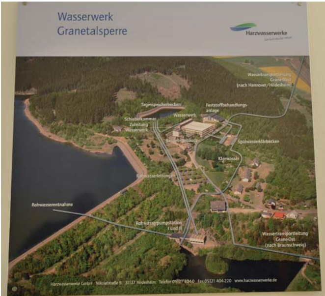
Bild 2: Übersicht Wasserwerk Granetalsperre, Quelle Harzwasserwerke GmbH
