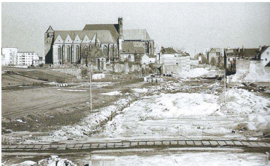
Abb.VIII-7: Der Bau der neuen Elbuferstraße vor 1970 (Quelle: Magdeburger historische Hefte)
