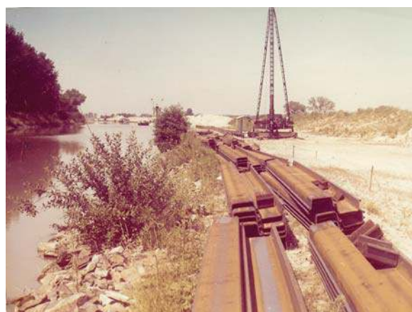
Abb. VIII-12 : Ausbaustrecke mit Spundwänden um 1980 (Foto: WSB Magdeburg)
