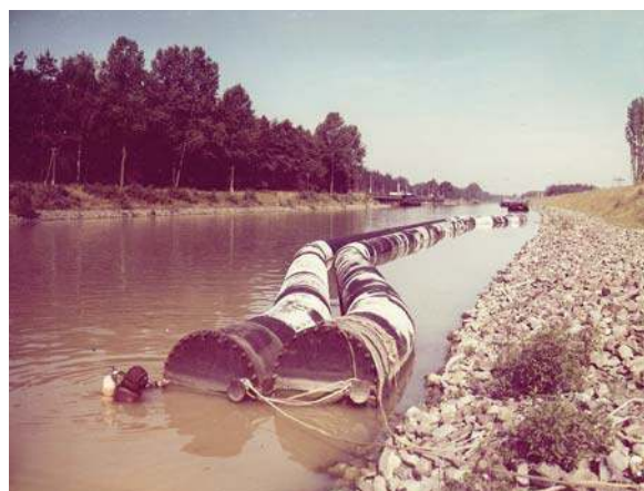
Abb. VIII-13: Taucher neben zwei Dükerrohren vor dem Einschwimmen (Foto: WSB Magdeburg)
