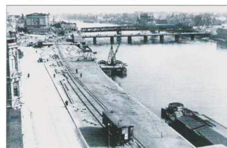
Abb. VIII-2: Behelfsbrücke vom Juni 1945 und dahinter die provisorisch wiederaufgebaute Strombrücke Magdeburg 1946 (wurde 1965 durch die heutige Strombrücke ersetzt)
