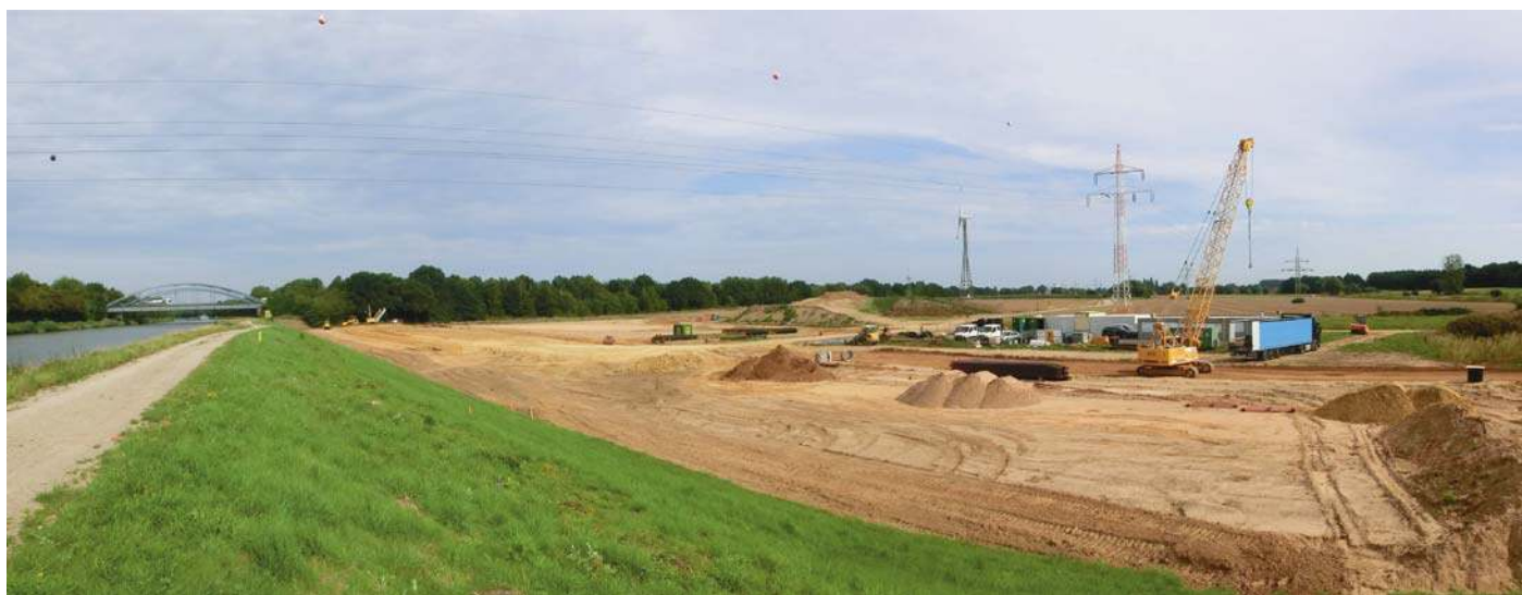
Bild: Baufeld Containerterminal RegioPort Weser im August 2017
