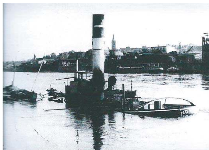
Abb. VIII-5: Ein gesunkener Schleppdampfer vor der Magistratsstrecke in Magdeburg-Buckau 1945 (Quelle: Archiv Klinder)
