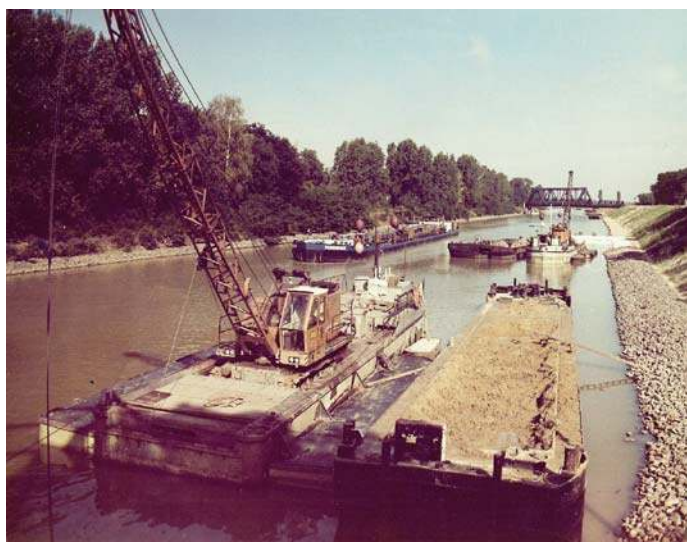
Abb. VIII-10 : Uferbefestigung am verbreiterten Kanal um 1980 (Foto: WSB Magdeburg)
