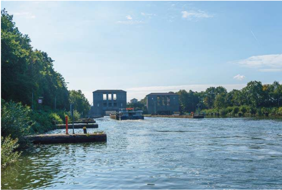
Abb. 4: Unterer Vorhafen der Schleuse Üfingen
