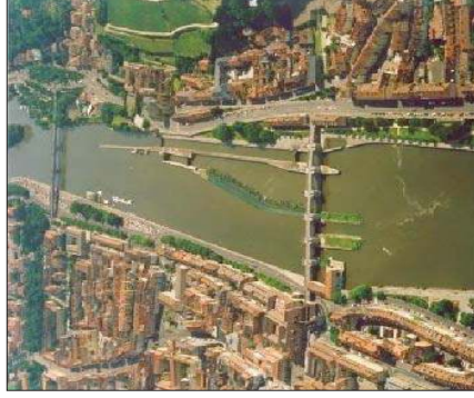
Die Main-Staustufe Würzburg an der Alten Main-Brücke mit dem Wasserkraftwerk Untere Mainmühle (links-1921/22) sowie der Wehranlage und den Schleusen (von 1954). Foto: WSA Schweinfurt
