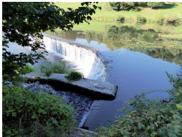
Blick auf den Fischaufstieg am oberen Wehr Fürfurt (rechts)
