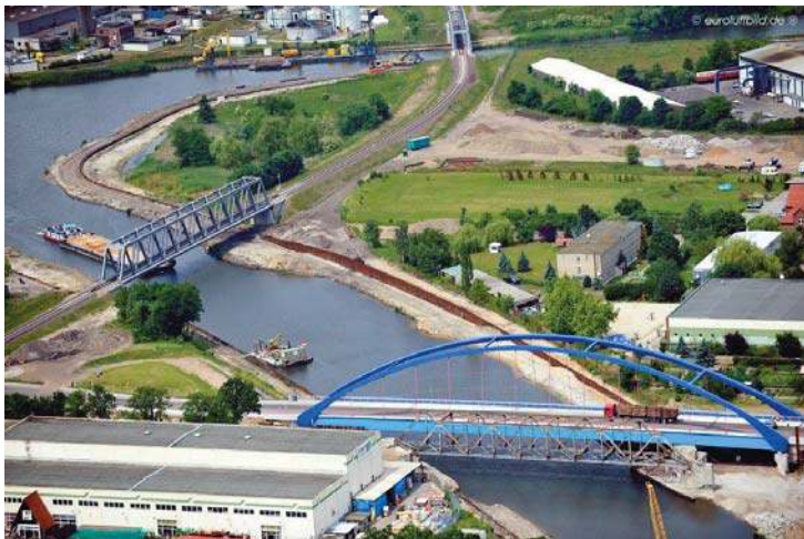
Bild 5.: Straßenbrücke B15 „Friedensbrücke Genthin“ (© eurolufbild.de).
