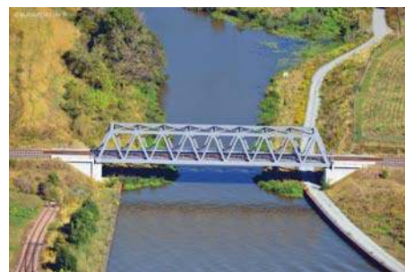
Bild 4.: Eisenbahnüberführung B26 über den Roßdorfer Altkanal (© euroluftbild.de).
