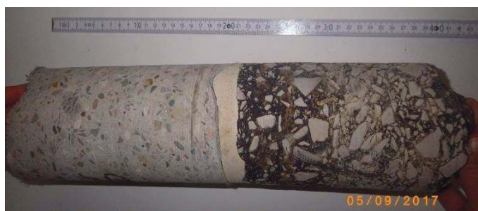
Abb. 9 Bohrkern der Erfolgskontrolle
