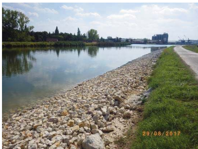
Abb. 8 Endzustand mit aufgelegten Wasserbausteinen und vollverklammertem Deckwerk
