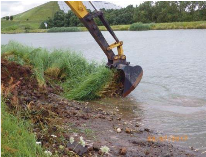
Abb. 6: Instandsetzungsdurchführung – Freilegen der Asphaltbetondichtung
