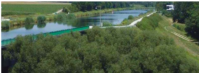
Abb. 2 Dammstrecke mit mehreren Schilffeldern in der Wasserwechselzone
