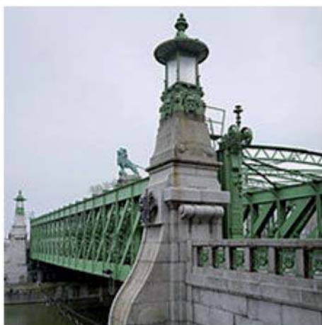
Wien, die Schmelzbrücke
