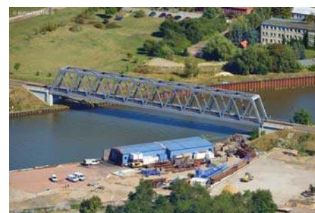
Bild 3.: Eisenbahnüberführung B15 über den Elbe-Havel-Kanal (© euroluftbild.de).
