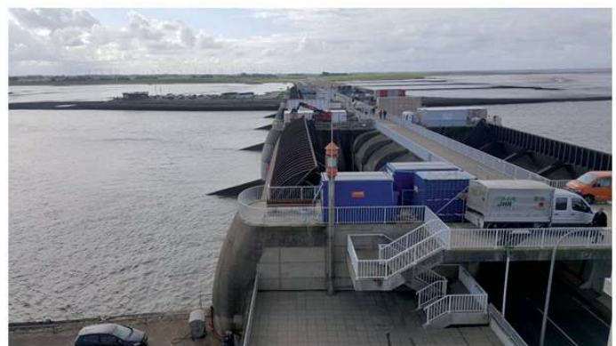
Bild 2: Eidersperrwerk, Verschlüsse des Sielbauwerks; J. Preuss
