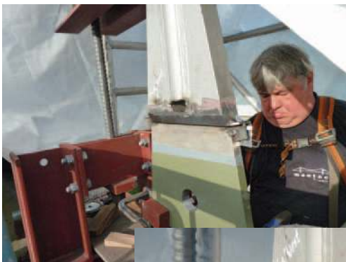
Bild 19: Vorbereiten der Schweißnaht
