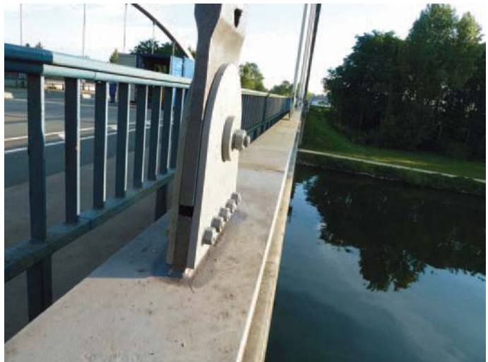
Bild 24: Instandgesetzter Hängeranschluss
