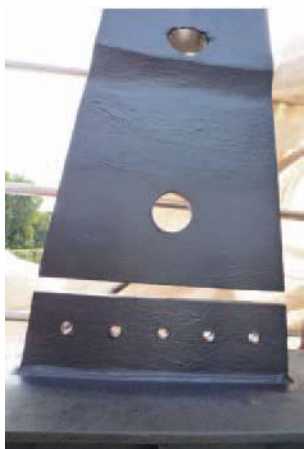
Bild 21 und 22: Anschluss Blech 25 mm-Ansicht
