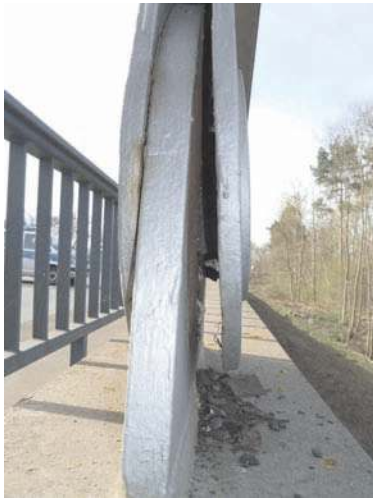
Bild 4: geschädigter Hänger
