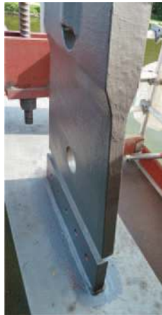
Bild 24: Instandgesetzter Hängeranschluss
