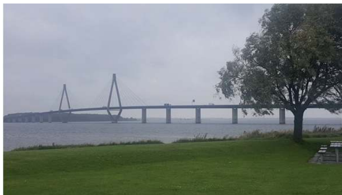
Bild 9: Die Brücke über den Großen Belt; J. Preuss
