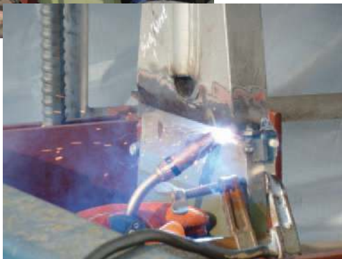
Bild 20: Schweißen des oberen Anschlusses
