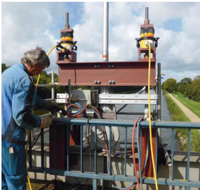
Bild 7: Montierte Hilfskonstruktion
