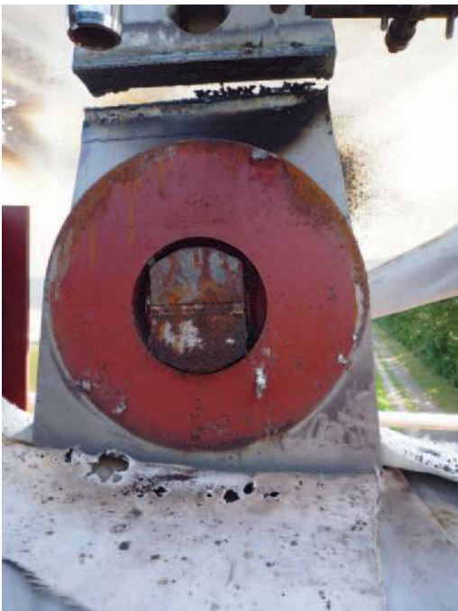
Bild 12: getrennter Hängeranschluss
