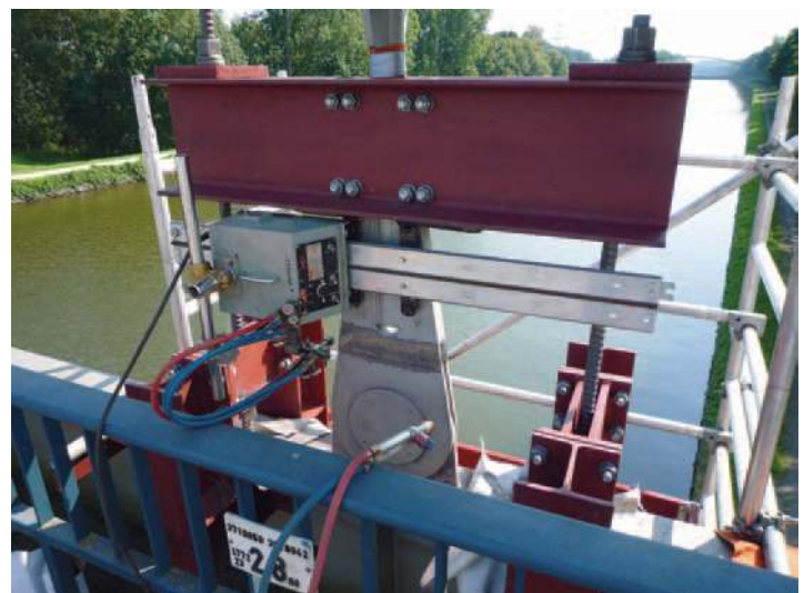
Bild 10: Montierte Trennvorrichtung
