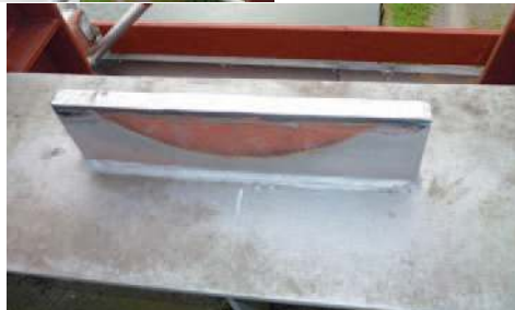
Bild 18: Vorbereitung unterer Anschluss
