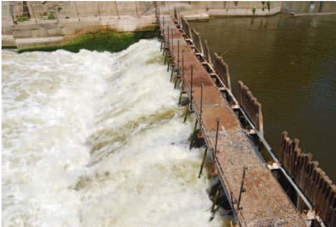
Bild 4: Nadelwehr der Werra-Staustufe
