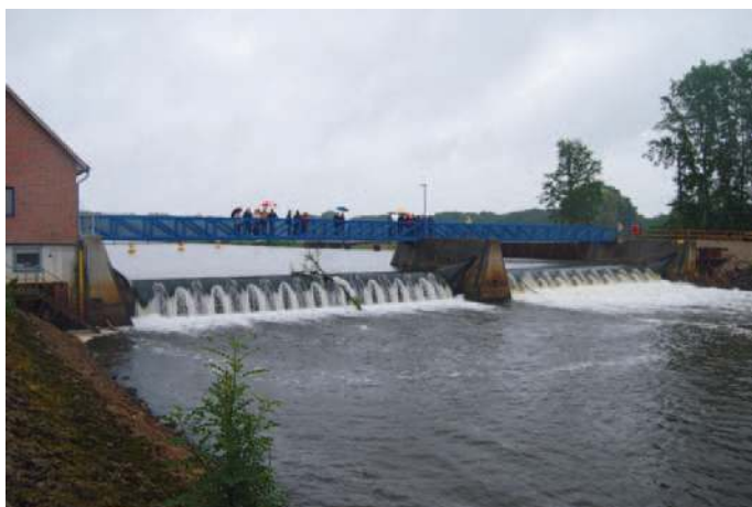
Bild 2: Schlauchwehr von Bannetze
