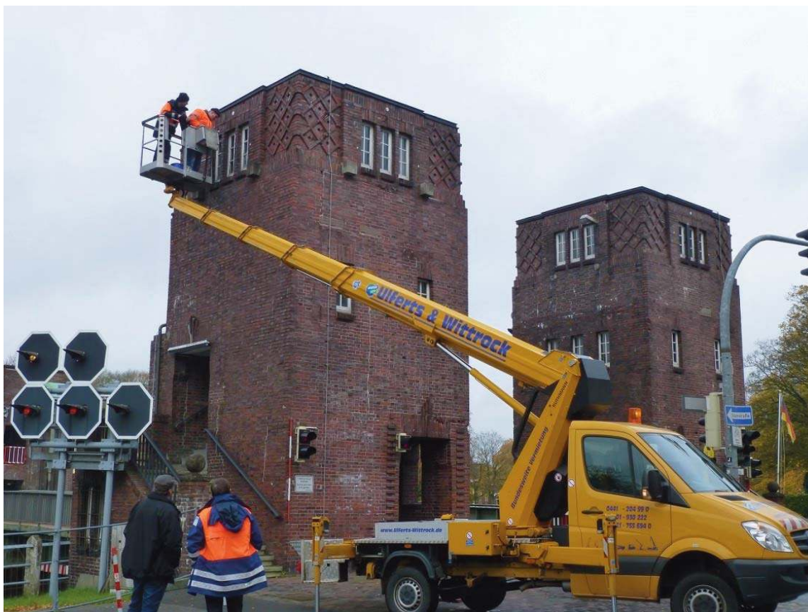
Abbildung 4: Bauwerksprüfung am Mauerwerk der Cäcilienbrücke
