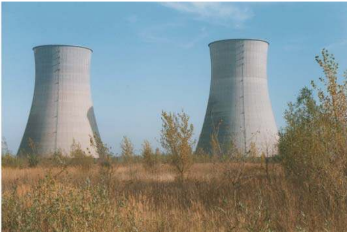
Abb. IX-4: Zwei der 3 Kühltürme (150m hoch) kurz vor der Sprengung am 28.10.1999 (Der erste war bereits 1994 gesprengt worden.) – Foto: privat
