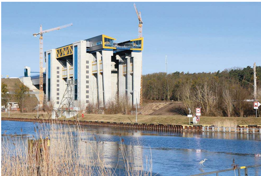
Bild 11: Blick vom Unterwasser des alten Hebewerkes, Foto: WNA Berlin, 21.03.2018
