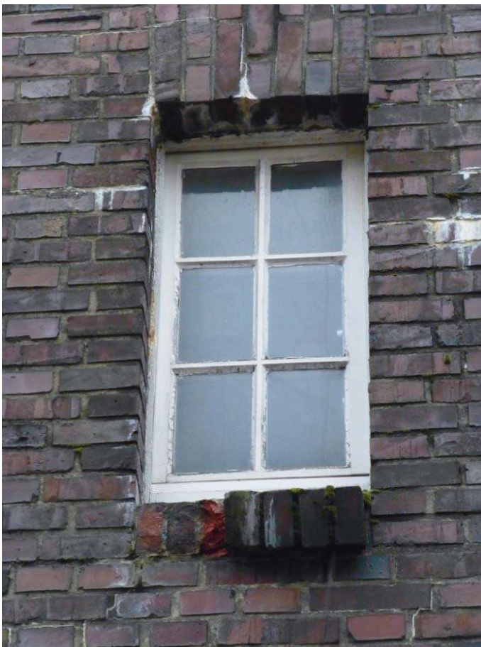
Abbildung 2: Schäden am Mauerwerk
