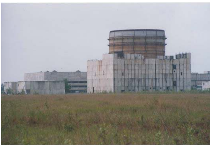
Abb. IX-3: Reaktorblock 1 des KKW Stendal vor dem Abbruch (Foto 2005: privat)
