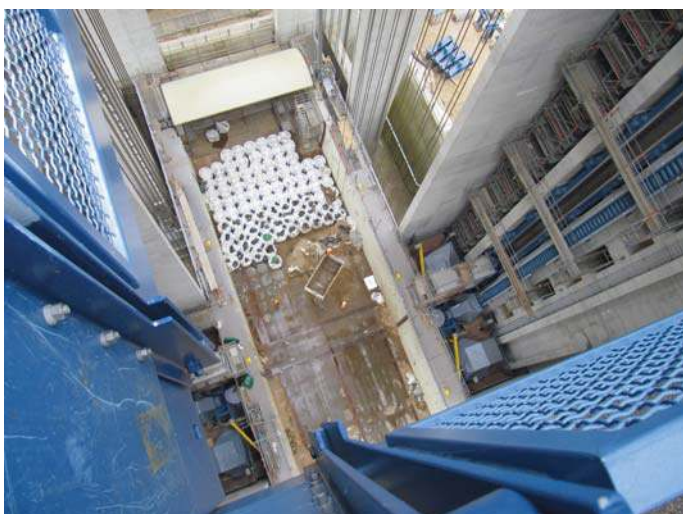
Bild 6: Blick in den teilgeleerten Trog; Foto: S. Schröter, 10.07.2018
