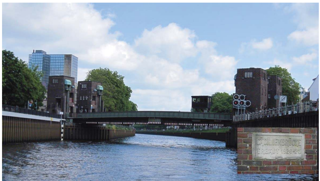
Abbildung 1 : Die Cäcilienbrücke Oldenburg
