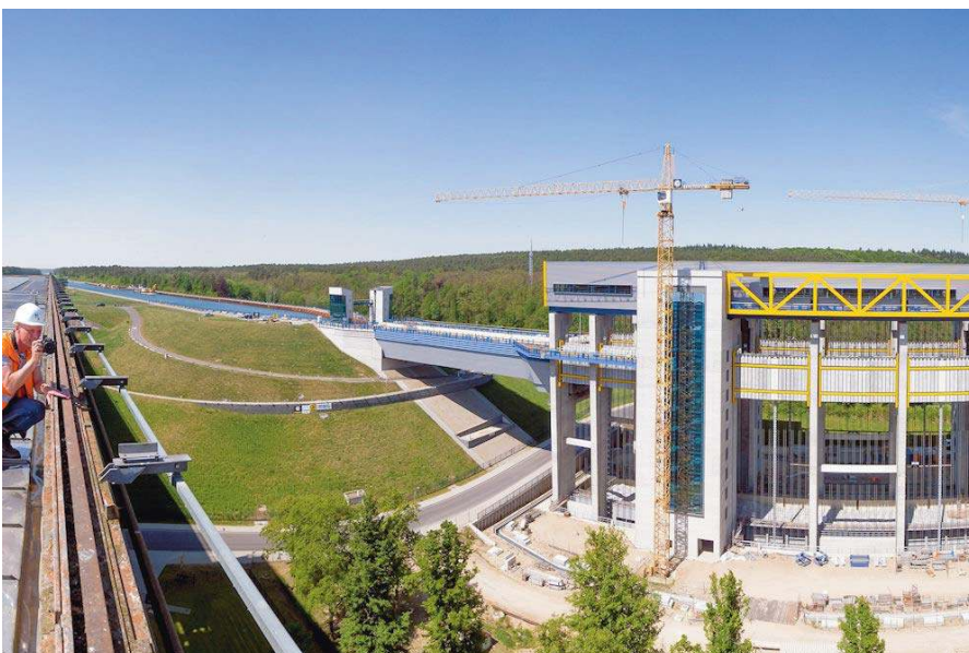
Bild 12: Blick Richtung Oberwasser; SHW mit Brücke, Foto: WNA Berlin, 09.05.2018
