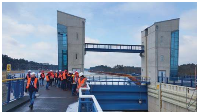
Bild 7: Blick Richtung oberer Vorhafen, Foto: D. Winkler, 20.03.2018
