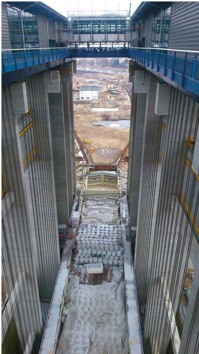
Bild 5: Blick in den mit Sandsäcken ballastierten Trog Richtung unterer Vorhafen, Foto: M. Mäder, 20.03.2018
