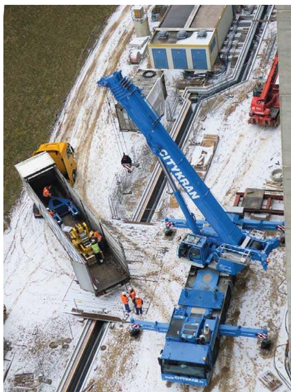
Bild 9: Anlieferung Bauteile für Trogantrieb, Foto: WNA Berlin, 20.03.2018
