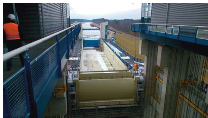
Bild 8: Blick in die Kanalbrücke Richtung Oberer Vorhafen, Foto: M. Mäder, 20.03.2018
