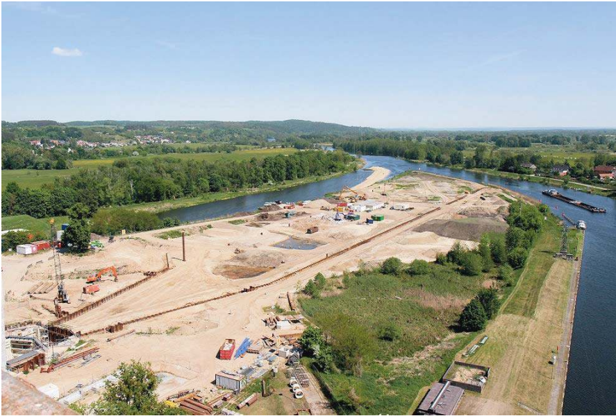
Bild 10: Blick über den künftigen unteren Vorhafen, Foto: WNA Berlin, 09.05.2018
