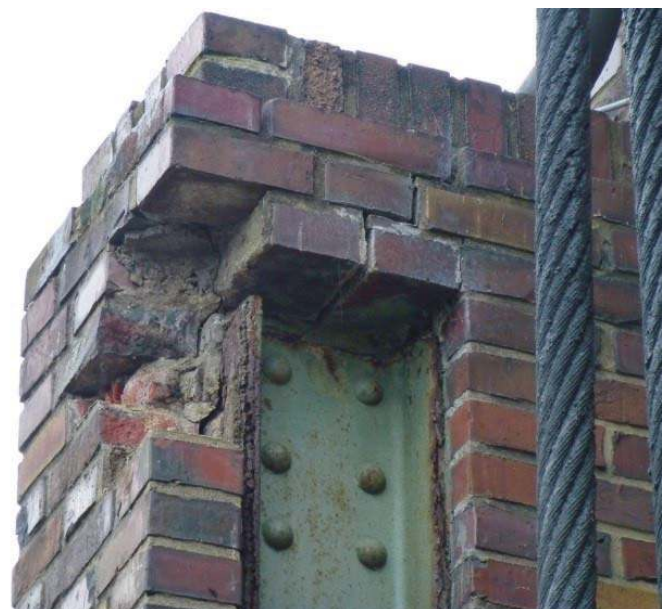
Abbildung 2: Schäden am Mauerwerk
