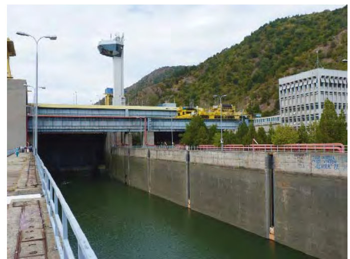
Kuppelschleuse mit insgesamt 30 m Hubhöhe. Abstieg über 135 Stufen in die Turbinenhalle. 6 Turbinen mit je 200 MW zur Abdeckung von 50 % des Energieverbrauchs Rumäniens.
