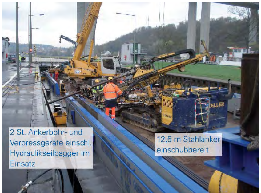
Abb. 3: Bohrgeräte im Einsatz auf dem Doppelponton Helene
