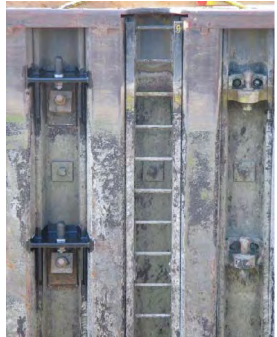
Abb. 1: Spundwand neuen-alten Nischenpollern
