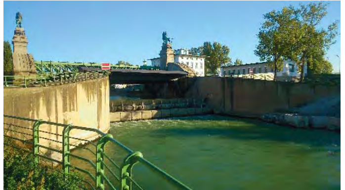
Stauanlage Nußdorf – bestehend aus Wehr, Schleuse, Fischaufstiegsanlage sowie Kreuzungsbauwerk – historische Straßenbrücke die „Schmerlbrücke“
