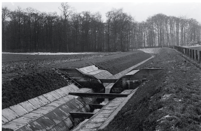
Der regulierte Deininghauser Bach. Hier gerade frisch ins Betonkorsett gefasst, 1937 © Archiv, Emschergenossenschaft
