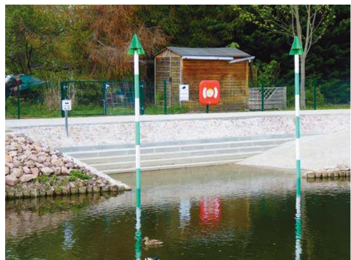
Abb. 9: Umtragestelle oberer Vorhafen
