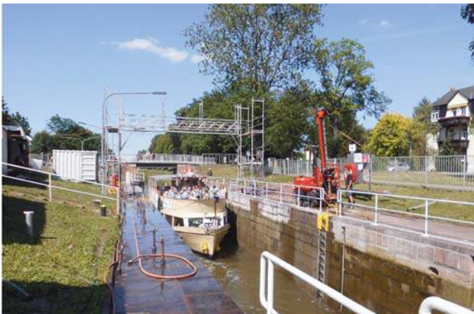
Abb. 5: Kleine Saaleschleuse Meuschau – Verpressarbeiten
