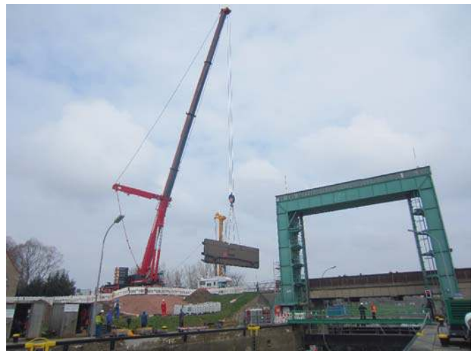
Abb. 2: Schleuse Calbe, Ausbau Untertor April 2017
