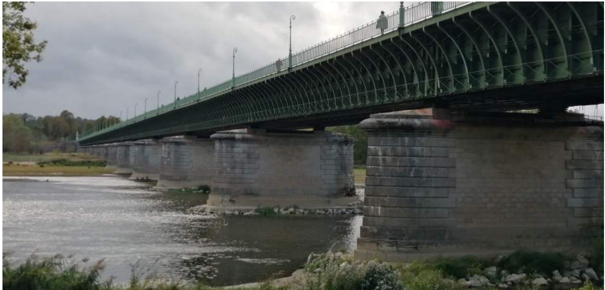
Abb. 8 - Gesamtansicht der Kanalbrücke bei Briare über die Loire
