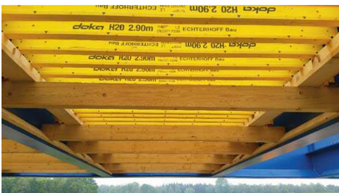
Abb. 2: Untersicht der Brücke mit Schalungsträgern
