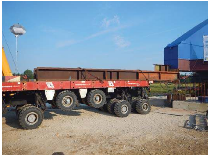
Abb. 8: umgebauter SPMT mit Vorschubschnabel
