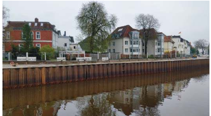
Foto 2: Fast fertig gestellte Baumaßnahme Hermann-Ehlers-Straße Oldenburg
