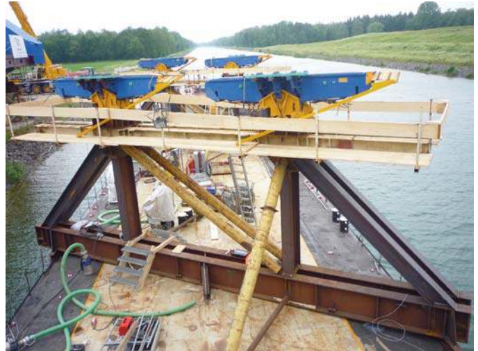
Abb. 4: Verschubschuh System SBN auf Ponton
