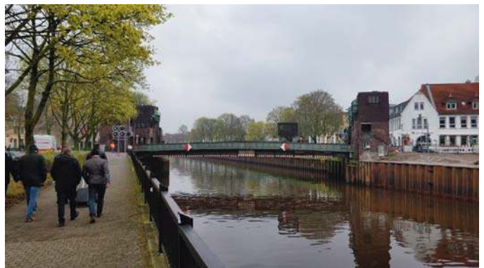
Foto 3: Cäcilien-Brücke in Oldenburg, „Zur Brückenwirtin“ und Baumaßnahme Hermann-Ehlers-Straße
