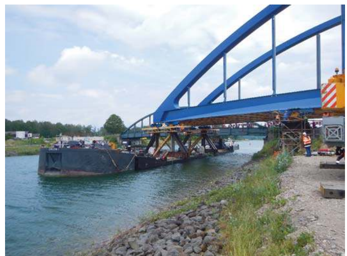
Abb. 5: Erreichen des Pontons (Schraffen sind bereits installiert)
