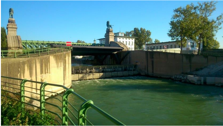
Stauanlage Nußdorf bestehend aus Wehr, Schleuse, Fischaufstiegsanlage sowie Kreuzungsbauwerk - historische Straßenbrücke die „Schemerlbrücke“
