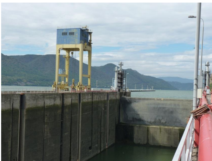
Schleusen-Plattform über 170 Stufen
