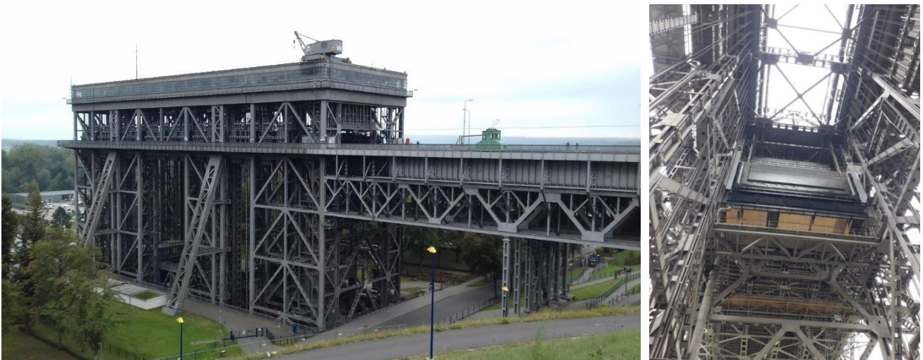
Nordansicht des alten Hebewerks und innerer Blick vom Trog zum oberen Haltungstor
