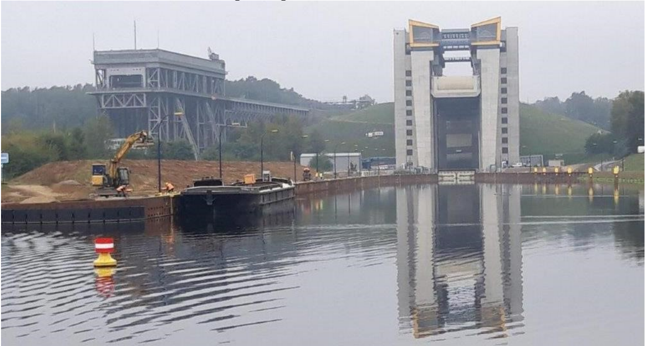
Blick vom Unterwasser auf die Schiffshebewerke in Niederfinow (36 m Hubhöhe) -links das alte Hebewerk (1927-34) -rechts das neue (Bau ab 2006 bis vorauss. 2021)
