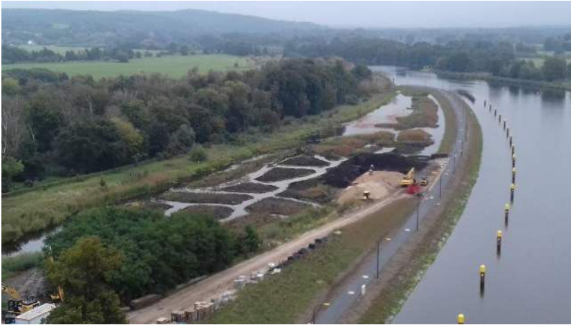
Der weite Blick ins Oderbruch mit dem künstlichen Niedermoor und dem fertiggestellten Unteren Vorhafen für das neue Schiffshebewerk
