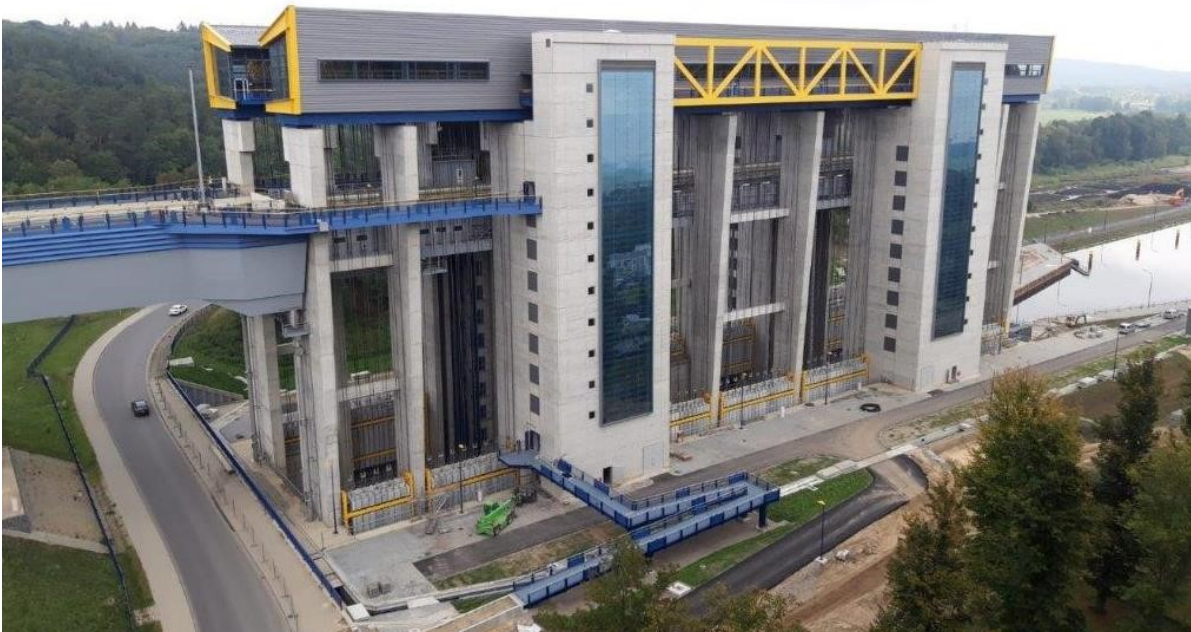
Südansicht des neuen Hebwerkes Niederfinow kurz vor Fertigstellung
