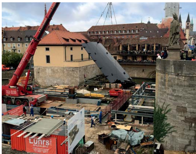
Bild 19: Einheben der Fischbauchklappe am Wehr Würzburg
