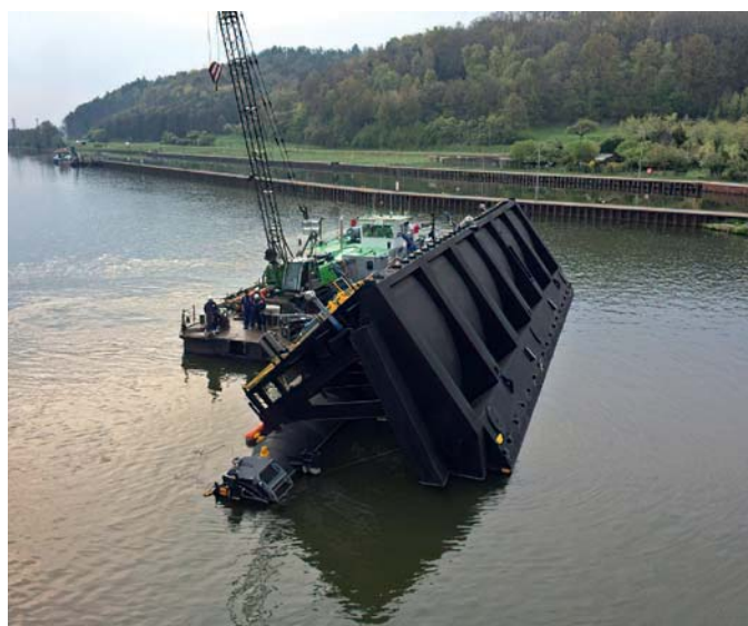
Bild 9: Einschwimmbarer Revisionsverschluss beim Einschwimmen im OW Viereth
