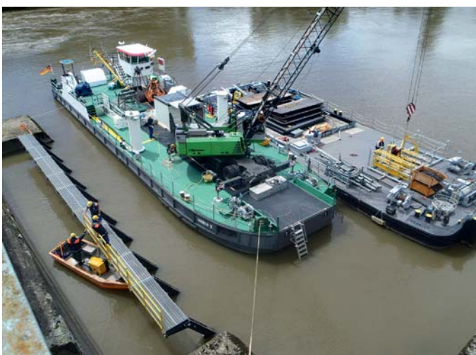
Bild 7 und 8: Stellen eines Revisionsverschlusses durch Beschäftigte des WSA Schweinfurt
