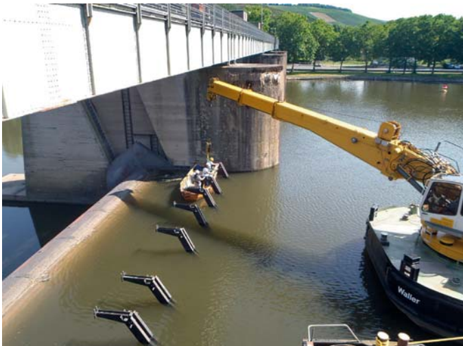
Bild 9: Einschwimmbarer Revisionsverschluss beim Einschwimmen im OW Viereth
