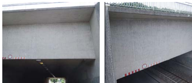
Bild 2 und 3: Unterführung U 164, MLK / Wertstraße in Minden
