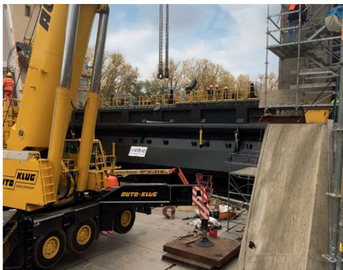
Bild 20: Einheben des Drucksegmentes mit Klappe am Wehr Viereth
