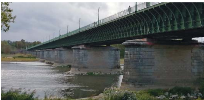
Bild 8: Gesamtansicht der Kanalbrücke bei Briare über die Loire
