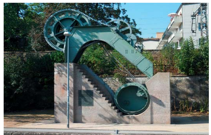
Bild 3: Modell eines Walzenwehres in Schweinfurt
