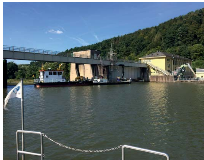
Bild 13 und 14: Komplettinhausung einer Wehrwalze
