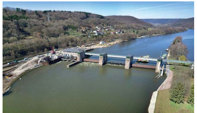
Bild 2: Blick vom Unterwasser auf die Staustufe Rothenfels
