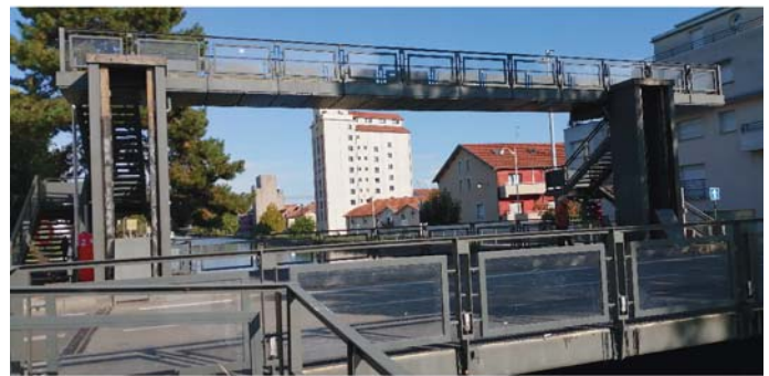
Bild 7: Hubbrücke über den Kanal
