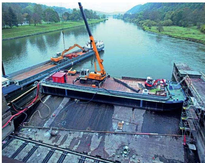
Bild 12: UW-Baugrubenumschließung am Wehr Rothenfels
