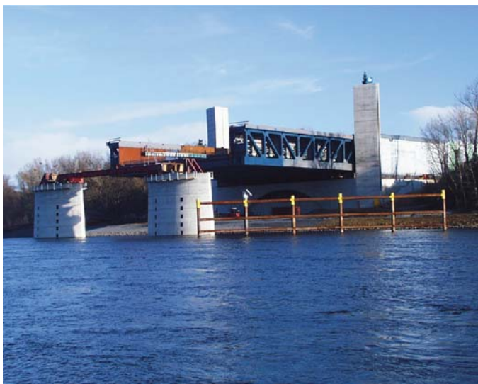
Abb. X-10: Der Verschub der ersten Strombrückenabschnitte von der Ostseite hatte Ende 1999 begonnen
