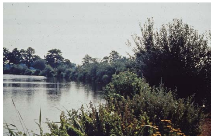
Abb. 8: Uferbewuchs an der Aller auf Geotextil und Schüttsteindeckwerk (40)
