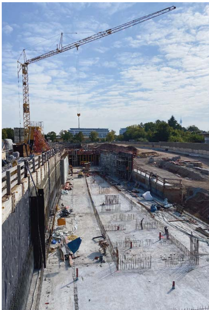
Abb. 1: Blick über das Baufeld
