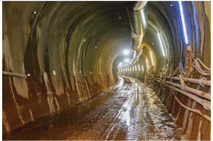
Abb. 3: Blick in eine der zwei Tunnelröhren
