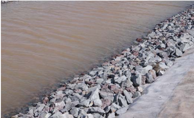
Abb. 7: Beispiel für ein Deckwerk auf geotextilem Filter
