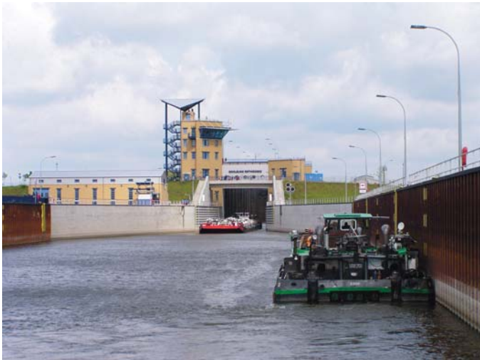
Abb. X-5: Betrieb im unteren Vorhafen der Schleuse Rothensee (links Pumpwerk, daneben Steuerstand mit oberer Aussichtsplattform)
