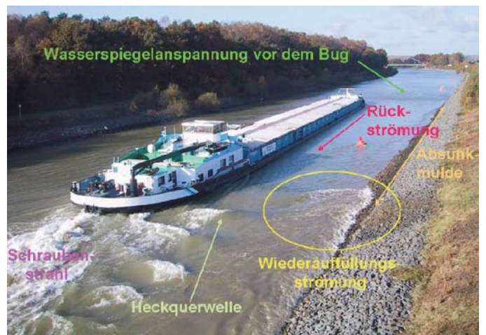
Abb. 2: Belastung des Deckwerks durch vorbeifahrende Schiffe [44]
