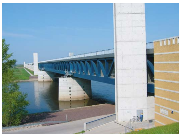
Abb. X-9: Die gesamte Kanalbrücke von Südosten gesehen (vorn die Strombrücke) Fotos: WNA Magdeburg
