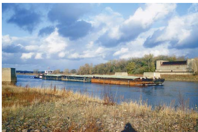
Abb. X-1: Sechser-Schubverband zwischen den Strompfeilern der unvollendeten alten Kanalbrücke (Foto: WNA Magdeburg)
