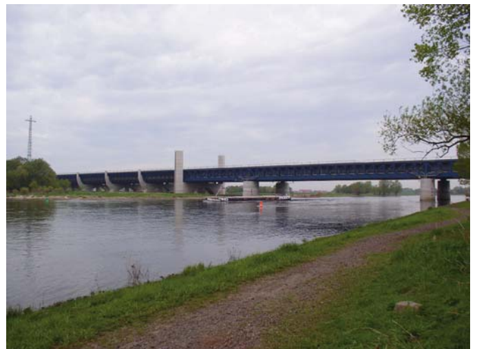
Abb. X-8: Ein Gütermotorschiff passiert das Wasserstraßenkreuz unter der Strombrücke
