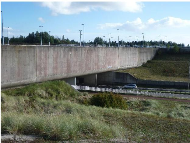
Das Naviduct befindet sich in Enkhuizen und verbindet das IJsselmeer mit dem Markermeer. Naviducte sind eine besondere Klasse eines schiffbaren Äqueducts, bei dem die Wasserstraße auch eine Schleuse umfasst. Es ist das erste Bauwerk dieser Art in der Welt, kostete 55 Mio. Euro und wurde 2003 eröffnet.
