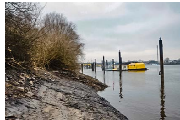
Entfernung von Deckwerksstrukturen zur Schaffung biologischer Diversität [9]
