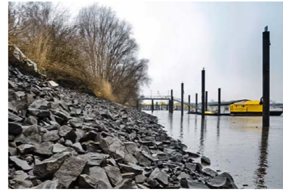
Entfernung von Deckwerksstrukturen zur Schaffung biologischer Diversität [9]
