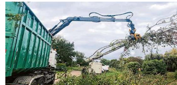
Bereits im Oktober 2020 wurden für den Wiederaufbau Bäume gefällt.
