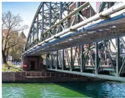
Bild 2: Gehwegbrücke und Straßenhubbrücke
