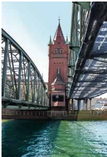
Bild 3: Straßenhub- und Eisenbahnhubbrücke
