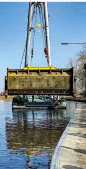
Torausbau/Toreinbau
