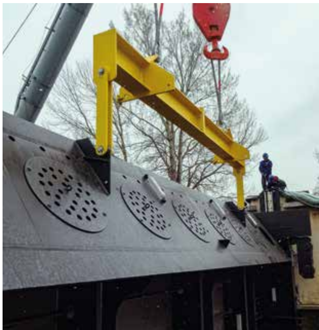
Torausbau/Toreinbau
