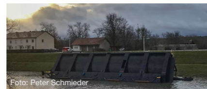
Nach seinem Einsatz an der Wehranlage Viereth liegt der Revisionsverschluss am Donnerstagmorgen wieder im Haßfurter Hafen.
