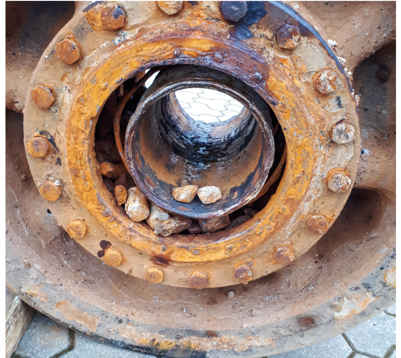
Rostiges Laufrad des Unterwagens, aus dem die Einzelteile des Lagers herausfallen
