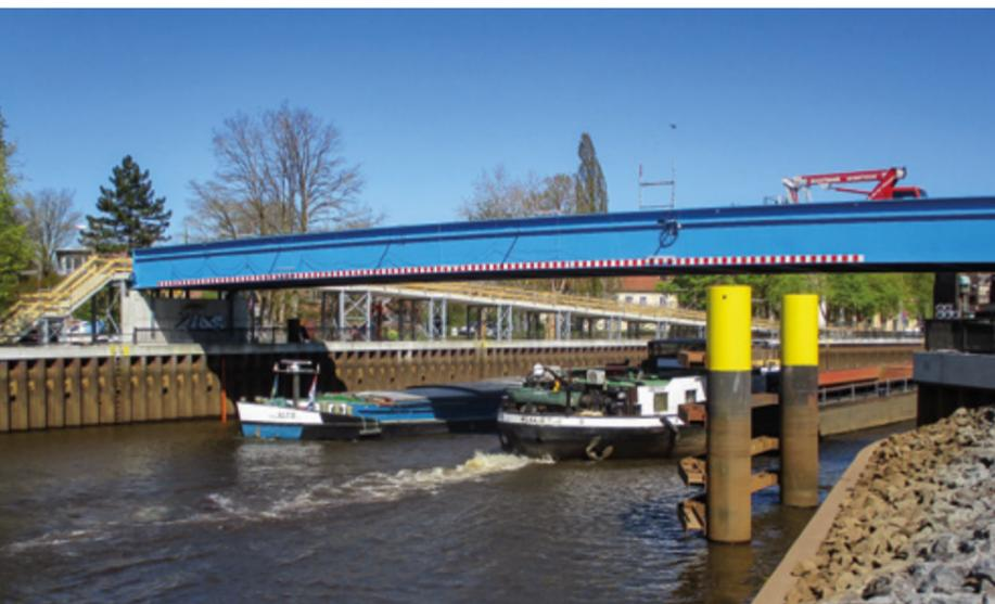
Abbildung 4: Im Bau befindliche Behelfsbrücke für Fußgänger und Radfahrer
