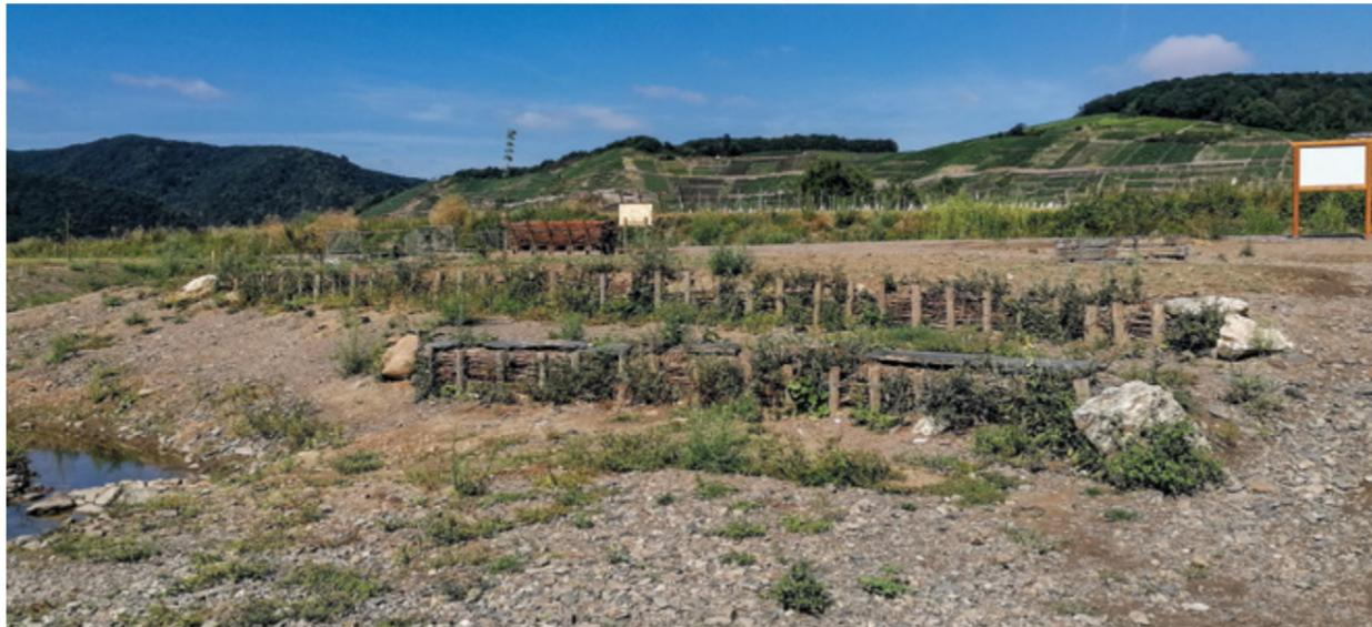
Uferbefestigung, welche im Ahrtal erstmals zum Einsatz kam. Das ingenieurtechnische Verfahren ist bis dato vor allem in Norddeutschland praktiziert worden. Bei dieser Technik werden zwischen Rundholzreihen Weidenruten (Faschinat) befestigt, die dann austreiben. Durch die Wurzeln der Weidenruten wird eine dauerhafte Stabilität der Befestigung erzeugt. Die Weidenruten wurden vor allem in den heimischen Außenbezirken an Mosel, Saar, Lahn und Rhein geworben und mit ins Ahrtal gebracht.
