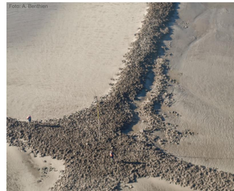
Schadensbild von schiffserzeugten Wellen im Einbindebereich von Buhne und Leitdamm
