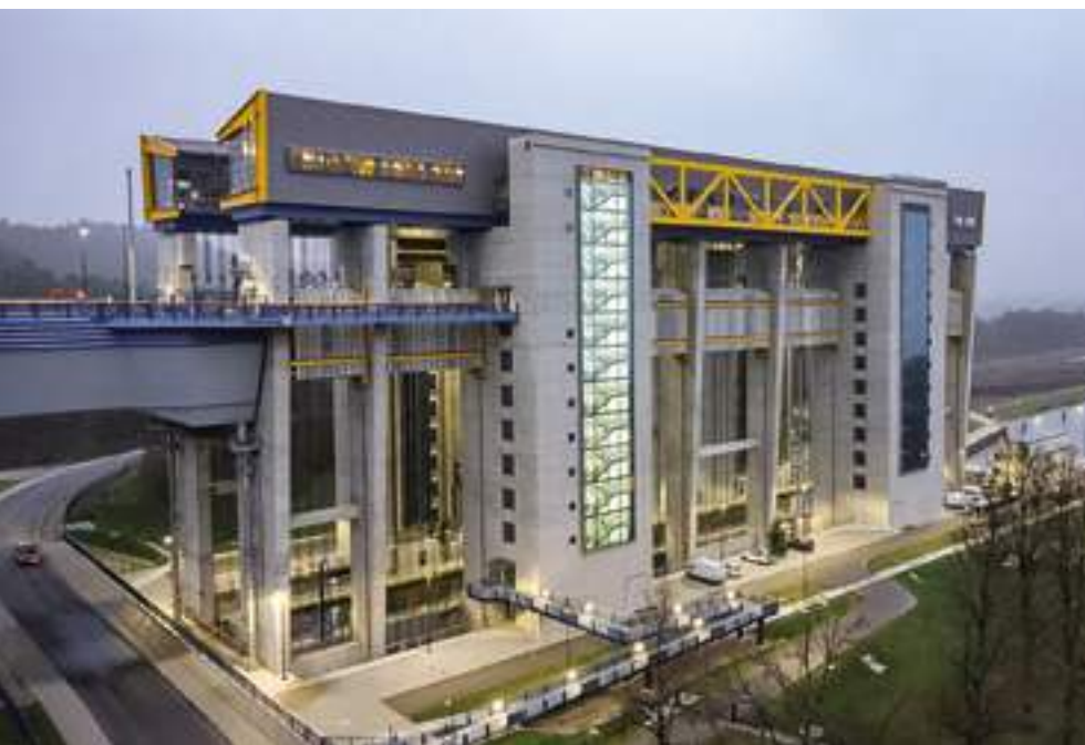
Bild 1: Das Neue Hebewerk Niederfinow Nord, von der Besucherplattform des Alten Hebewerkes aus Richtung Südwesten gesehen; Links die Straße aus Richtung Liepe unter der Verbindungsbrücke vom Oberen Vorhafen zum Hebewerk; Rechts der Untere Vorhafen mit der weiterführenden Havel-Oder-Wasserstraße in Richtung Oderberg und Hohensaaten.
