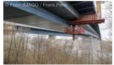
© Foto: IMAGO / Frank Peter Die Reparaturarbeiten an der beschädigten Olympiabridge in Kiel gehen weiter.
