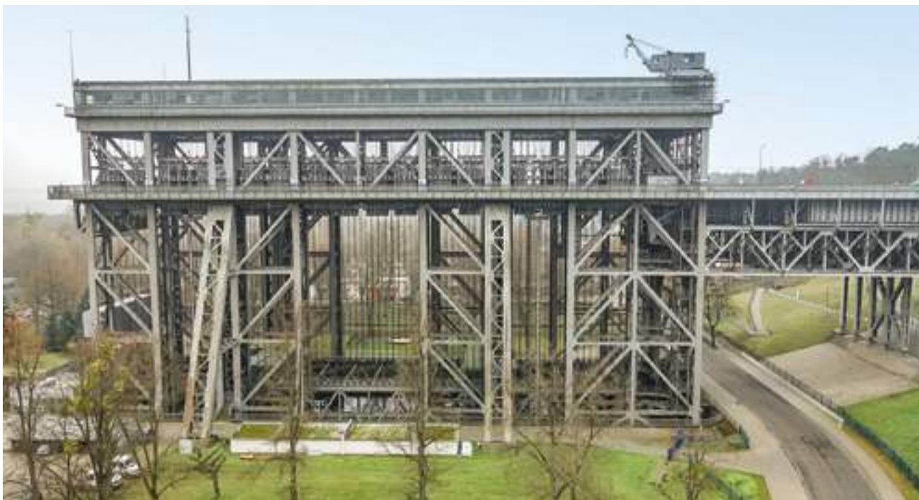
Bild 6: Das alte Hebewerk Niederfinow (erbaut 1926/27-1934); Ansicht von Norden; Auf der Südseite befindet sich der Besucherparkplatz mit dem Informationszentrum.
