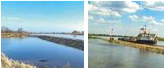
Abbildungen 4 + 5: Blick von km 204,2 bergwärts während des Baus und kurz nach Fertigstellung (01 + 07/2001; WSA Dresden)
