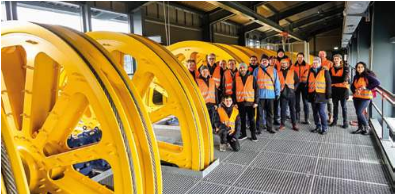
Bild 5: Die HTG-Besuchergruppe in einer der beiden Seiltragrollenhallen in der obersten Etage
