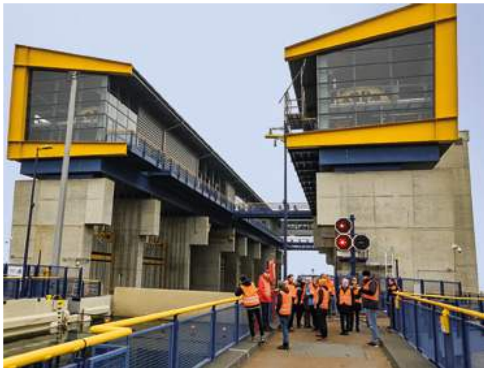
Bild 4: Auf der Plattform der Verbindungsbrücke zum Oberen Vorhafen, die sowohl wesentlich kürzer gestaltet wurde als beim alten Hebewerk und auch mit 12.5m nur die gleiche Durchfahrtsbreite hat wie der neue Hebewerkstrog; Nochmal drei Etagen höher oben als architektonischer Blickfang die gläserne Einhausung der beiden Seiltragrollenhallen auf den markanten durchlaufenden Seiltragrollenträgern aus Stahl.
