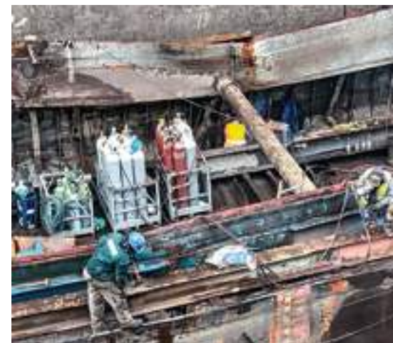
11. „Aussteifung mit Stahlträgern“
