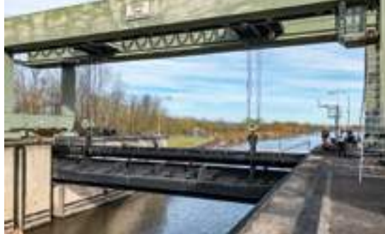
7. „Setzen der Revisionsverschlüsse zur Trockenlegung“
