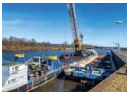
4. „Eisenerz-Umschlag im Unterwasser“
