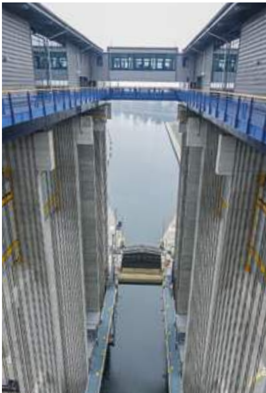
Bild 3: Blick von der Galerie im Bereich der Seiltragrollen-Hallen auf den unten stehenden Trog, welcher an insgesamt 224 Stück 60-mm-Stahlseilen hängt. Jeweils zwei eng nebeneinander liegende Seile werden über eine gedoppelte Seiltragrolle geführt (siehe auch Bild 5). Hinter dem Verbindungssteg oben quer ist der Steuerstand zu sehen. Wegen einer Überprüfung am unteren Haltungstor war der Bereich bis zum geschlossenen Sicherheits-Stemmtor gerade trocken gelegt.
