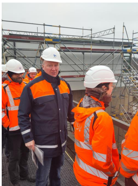
Bild2: Jan Gallas führt kompetent und kurzweilig über die Baustelle
