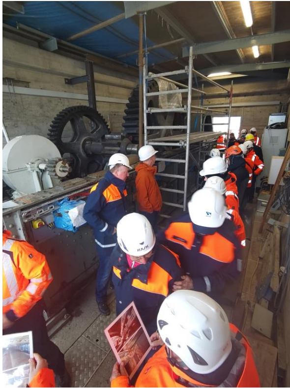
Bild3: Blick auf das Getriebe im Antriebshaus. Die Antriebsketten wurden durch Ketten aus Edelstahl ersetzt, korrodierte Verschleißteile aufgearbeitet, Dichtungen und Schleifflächen erneuert und Opferanoden ergänzt.
