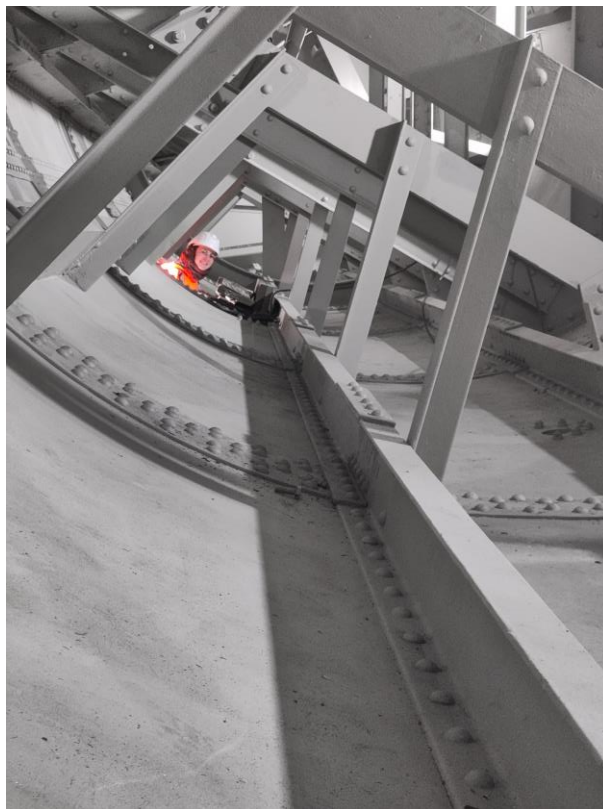
Bild4: Blick ins Innere der neu beschichteten Wehrwalze („hier riecht’s nach Marzipan...“)
