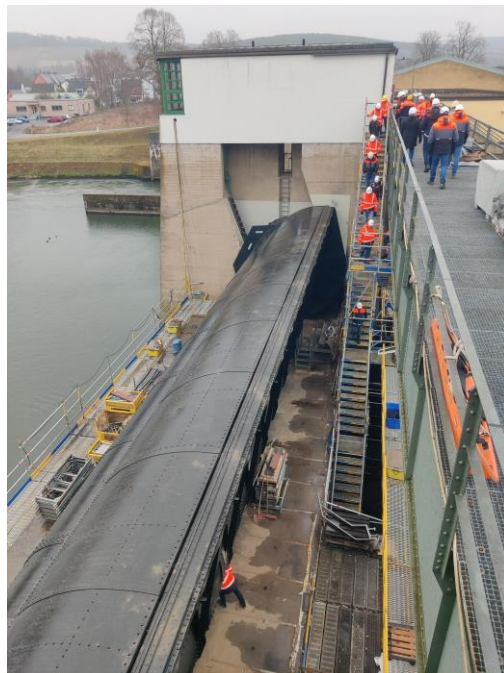
Bild1: Bei der 30 m langen Wehrwalze wurden bedarfsweise Bauteile verstärkt.
