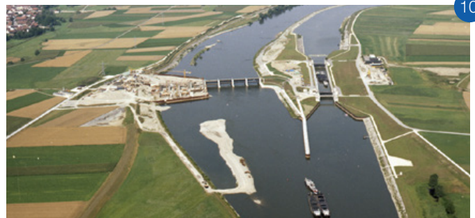
Der Bau der Staustufe Geisling erforderte u. A. eine umfangreiche Binnenentwässerung. (Foto Wolf 1982 / Archiv WSA Regensburg)
