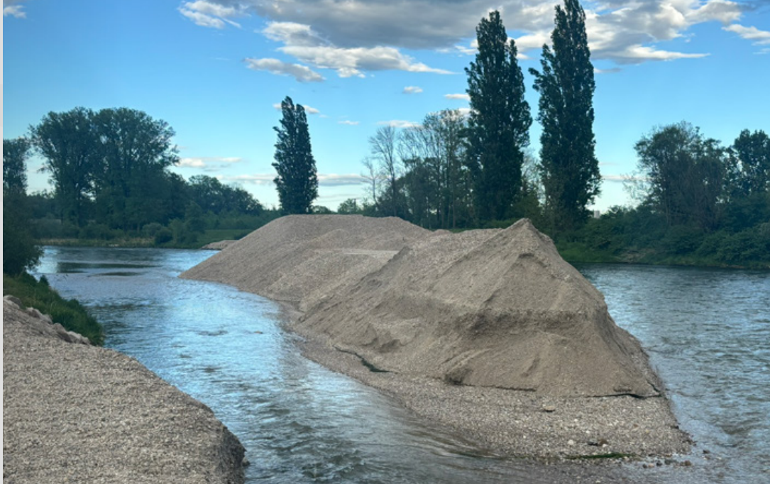
Bild 3: Geschiebezugabe in der Isar unterhalb der Staustufe Pielweichs bei Plattling
