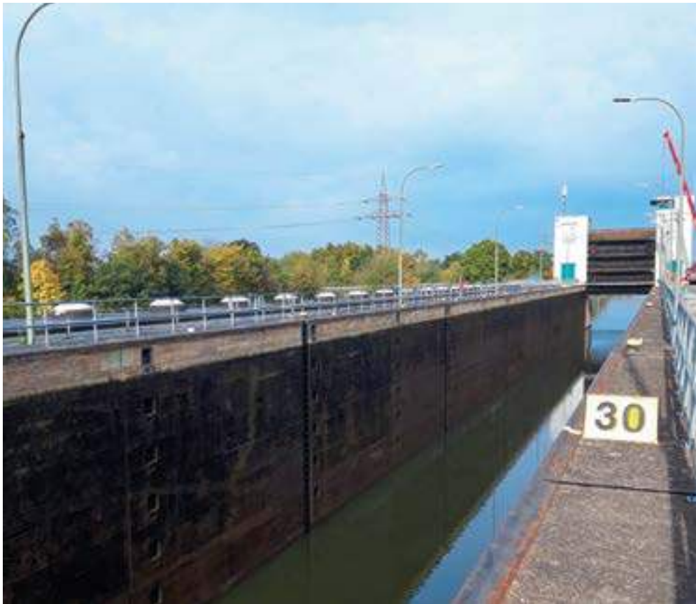
Schleuse Strullendorf: Blick in die Schleusenammer Richtung Untertor.
