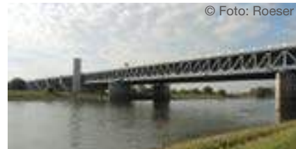
Blick auf die Trogbrücke.
