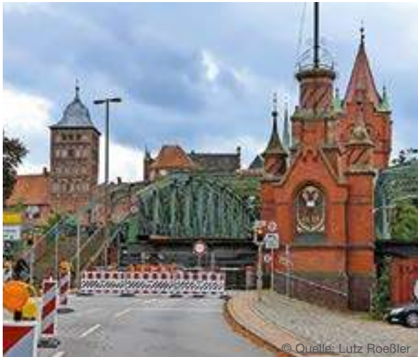
Seit Februar ist die Hubbrücke für die Autos komplett gesperrt. Das bleibt sie auch.
