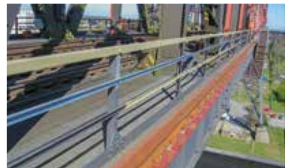
Abb. 8: neue Schwebefährenschienenträger mit Schiene AS86, Quelle WSA
