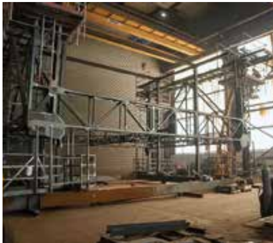
Abb. 12: Fertigung Fahrwagen, Quelle WSA
