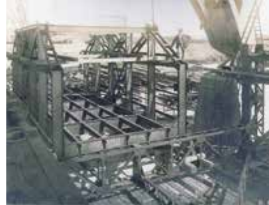
Abb. 4: Bau des Fahrwagen und Fahrbühne vor Ort
