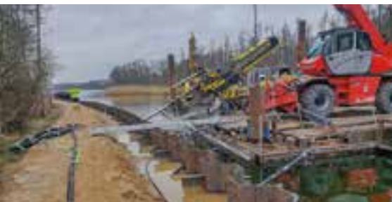
Bild 2: Ankerbohrarbeiten
