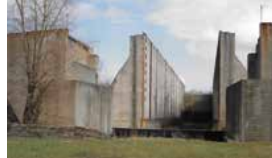
Abb.9 – Obere fast fertige Schleuse der Schleusentreppe Wüsteneutzsch (2x11m Hubhöhe) – Blick in die Kammer der Sparschleuse von der geplanten Zwischenhaltung aus – zwischen den fertigen Widerlagern der Straßenbrücke und den Kammerwänden fehlte noch das Unterhaupt und von der unteren Schleuse existiert bis heute nur eine wassergefüllte Baugrube- (Foto: Lothar Tölle-März 1991)
