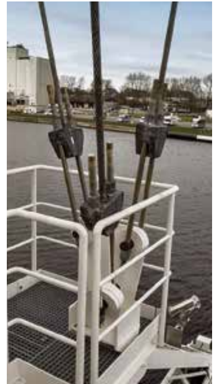
Abb. 18: Seilendbefestigung mit verstellbarer Vergusshülse, Quelle WSA
