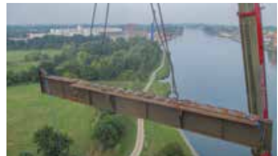
Abb. 6: Ausbau eines alten genieteten Schwebefährenschienenträger, Quelle WSA
