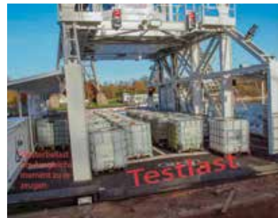
Abb. 19: Wasserballast als Ausgleich Westseite Fußweg (links) siehe auch [1] und Testlast auf Fahrbahn
