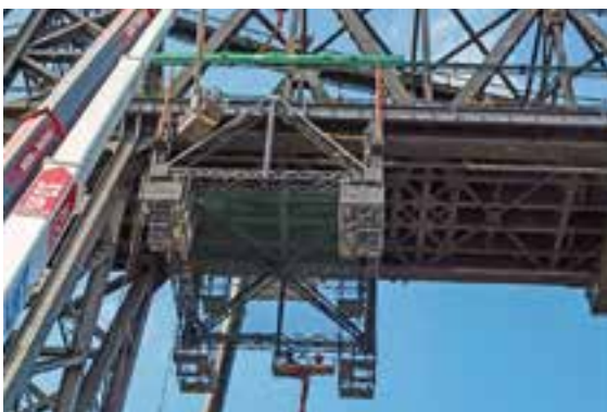
Abb. 16: Montage Fahrwagen Schuss 1, Sicht von Ost, Quelle WSA
