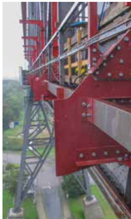
Abb. 7: neue Anschlusskonsolen, Quelle WSA
