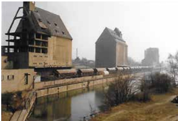
Abb.8 – Der bis 1943 fertiggestellte Nordkai des Hafens Leipzig-Lindenau im Jahre 1991 – damals noch Hafen mit Bahn-, aber ohne östlichen Wasserstraßenanschluss – der alte Silo im Vordergrund war durch einen Brand – in den 1960er Jahren stark beschädigt worden
