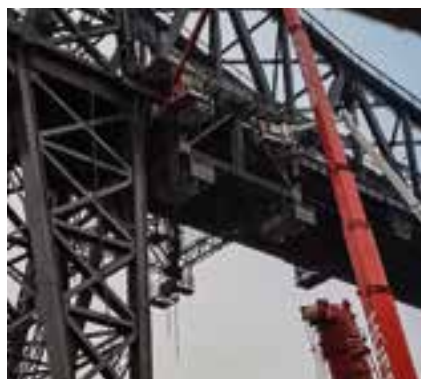
Abb. 17: Montage Fahrwagen Schuss 2, d.h. Balancier mit Laufstegen Ostseite, Quelle WSA
