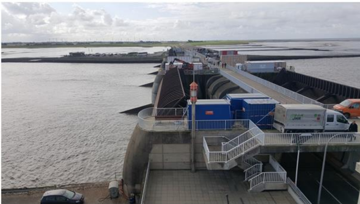
Eidersperrwerk; Verschlüsse des Sielbauwerks
